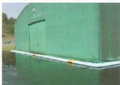
テント倉庫内への浸水防止に
