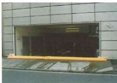
ビル駐車場内への浸水防止に
