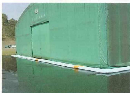
テント倉庫内への浸水防止に
