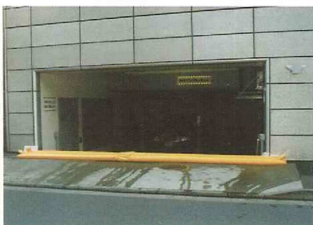
ビル駐車場内への浸水防止に
